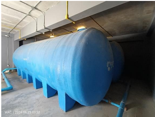
ถังเก็บน้ำดับเพลิงสำรองชั้นดาดฟ้า
