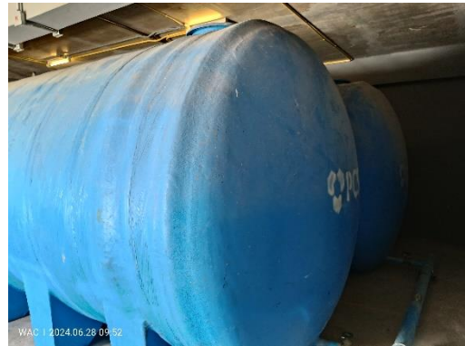
ถังเก็บน้ำดับเพลิงสำรองชั้นดาดฟ้า
