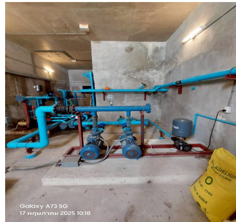
ปั๊มสูบน้ำใช้ขึ้นไป ถังเก็บน้ำชั้นหลังคา
